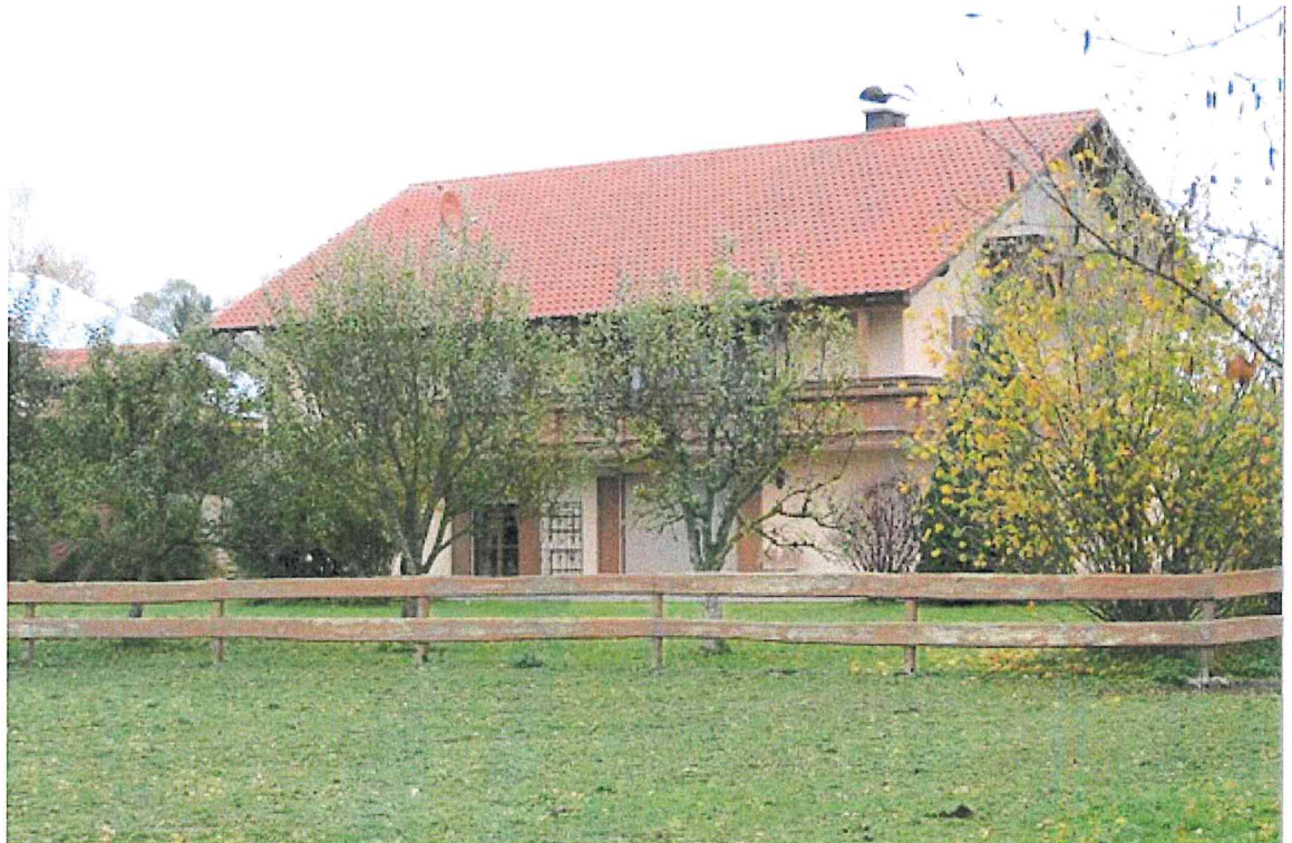
Abb.: vorhandenes Wohngebäude auf der Fl.Nr. 1028/1, Blick von Südwesten
